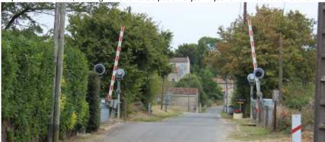
Figure 67 : Passage à niveau de Pouzzat de la ligne Niort-Ruffec (source : ATER Environnement, 2017)
