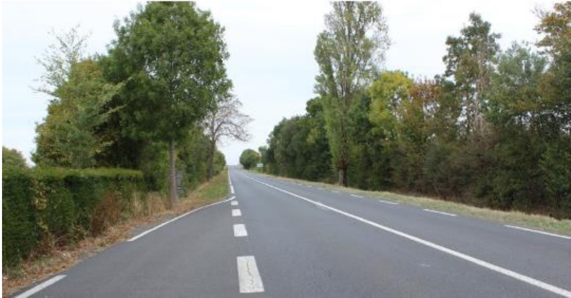
Figure 78 : D911 au niveau de la Revetizon (source : ATER Environnement, 2017)
