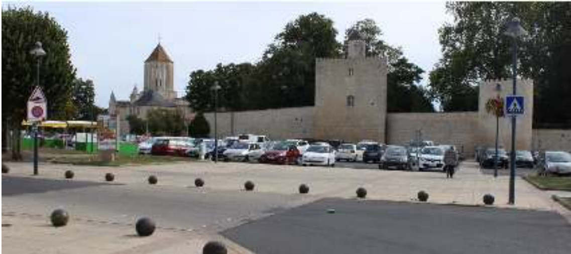
Figure 84 : Enceinte médiévale de Surgères (source : ATER Environnement, 2017)
