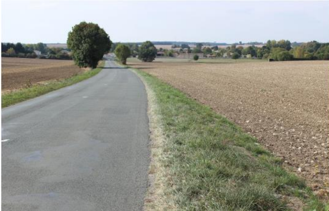
Figure 104 : D111 en direction de Boisse (source : ATER Environnement, 2017)
