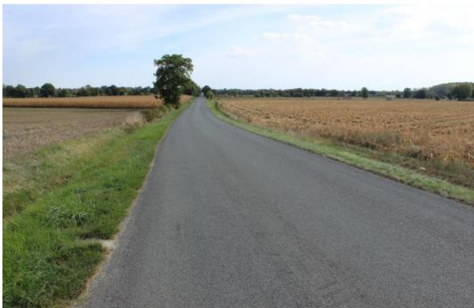
Figure 105 : D119 entre le Coudret et la Motte Aubert (source : ATER Environnement, 2017)
