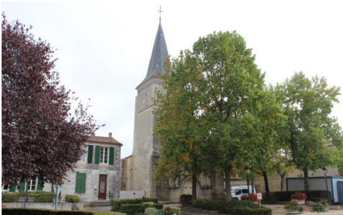
Figure 85 : Eglise de Saint-Georges-du-Bois (source : ATER Environnement, 2017)
