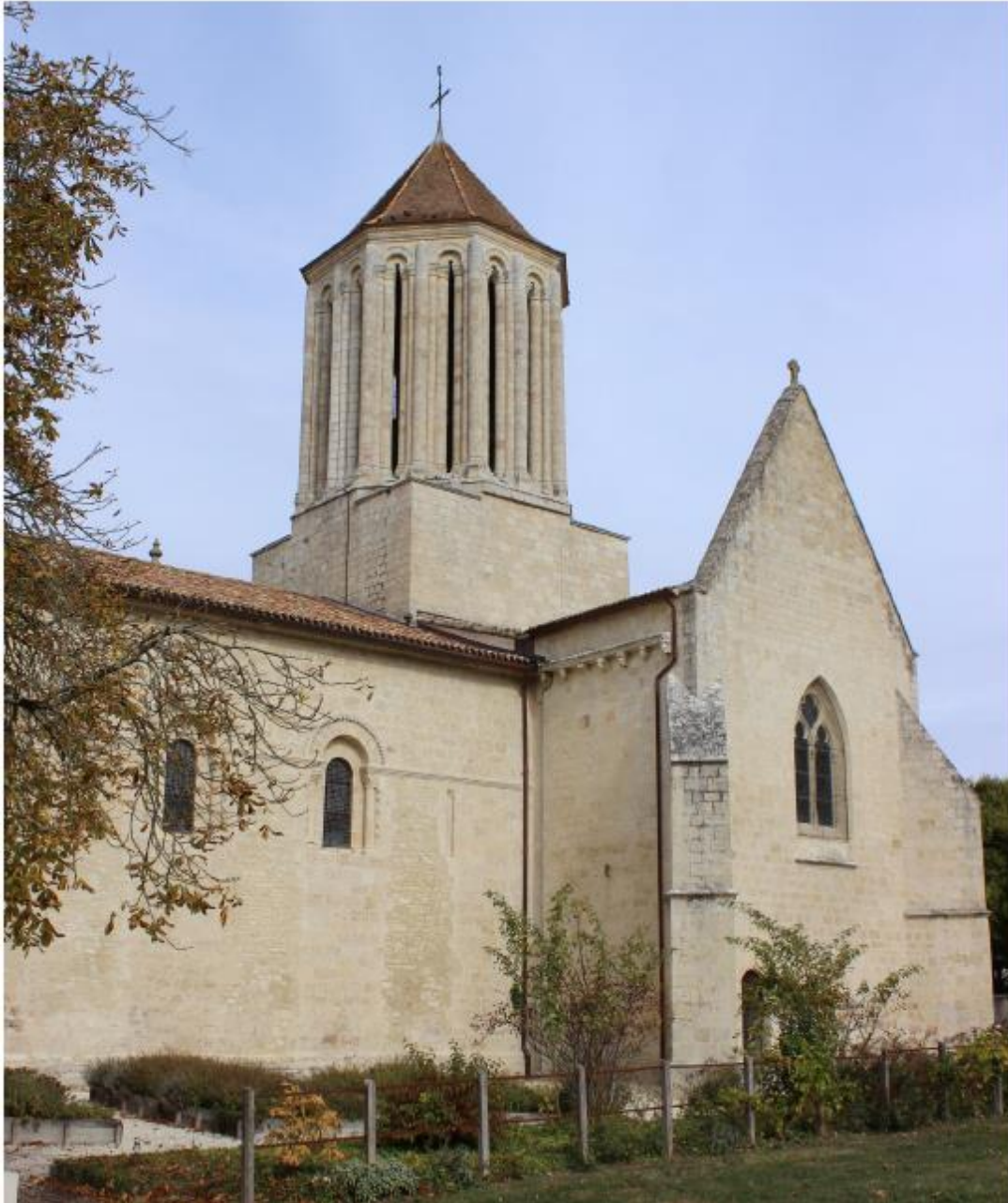
Figure 91 : Eglise de Surgères sur le Chemin de Saint Jacques de Compostelle (source : ATER Environnement, 2017)
