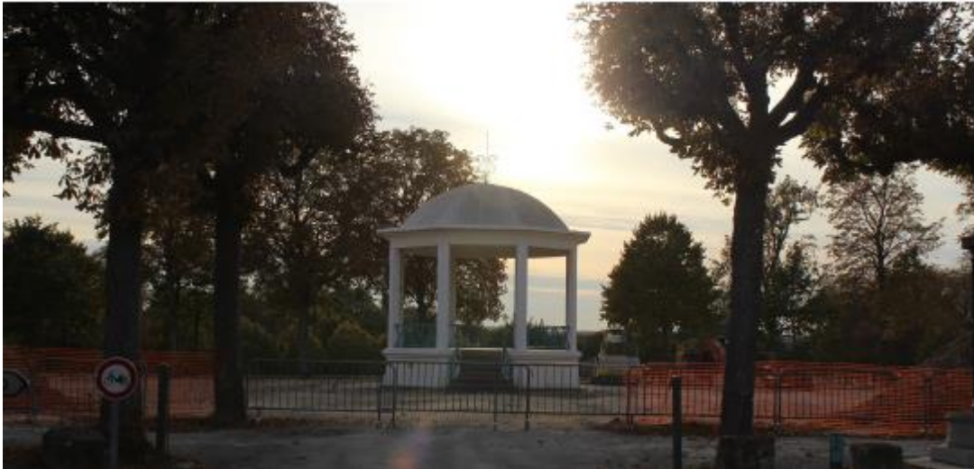
Figure 86 : Kiosque à musique en travaux, Mauzé-sur-le-Mignon (source : ATER Environnement, 2017)
