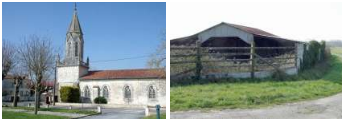
Figure 146 : Type de bâti pouvant abriter des chiroptères à proximité du site (à gauche : Eglise de Marsais / à droite : Grange au lieu-dit le Mas de Praises)(source : Les Snats, 2017)
