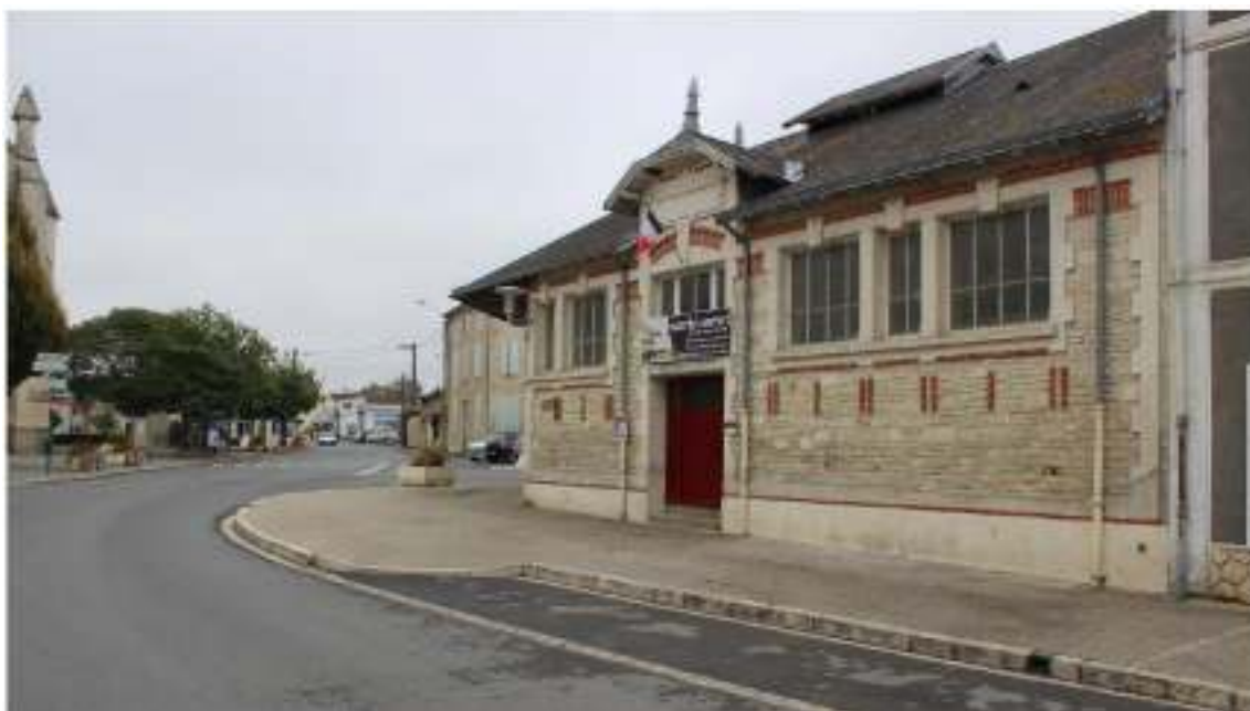
Figure 71 : Mairie de Saint-Hilaire-la-Palud (source : ATER Environnement, 2017)
