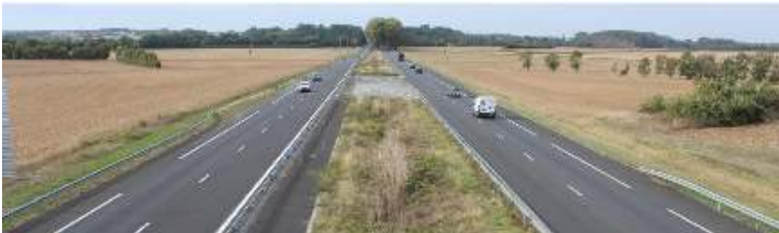
Figure 79 : N11 depuis le pont de Prin-Deyrançon (source : ATER Environnement, 2017)
