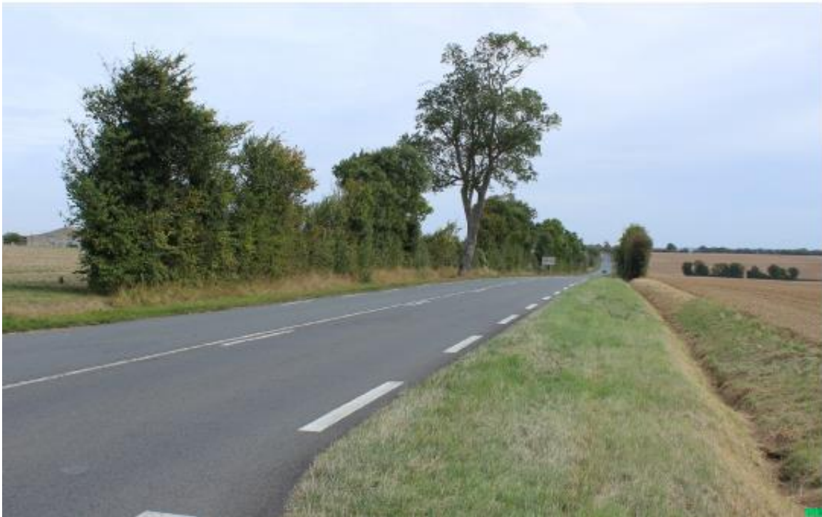
Figure 83 : D939 à hauteur de Charentenay (source : ATER Environnement, 2017)
