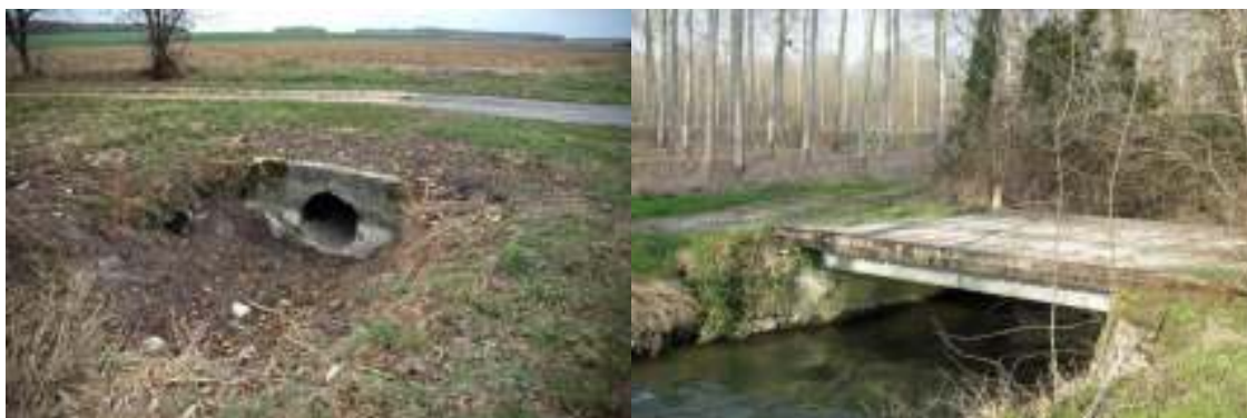
Figure 149 : Buse en béton (à gauche) et pont en bois à proximité du site (à droite) (source : Les Snats, 2017)
