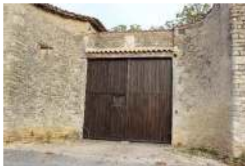
Les portes du château d'Olbreuse à Usseau
