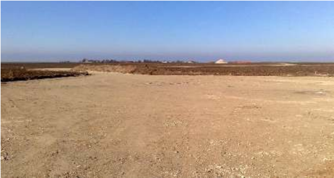
Figure 35 : Exemple d'aire de montage, grave compactée sur géotextile
