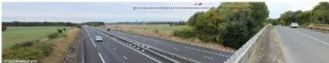
Figure 80 : A10 depuis la D53 (source : ATER Environnement, 2017)
